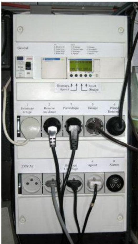
Exemple d'un tableau électrique, la partie supérieure abrite un automate Zelio de Schneider qui assure la fonction d'osmoteur et de remplissage de la réserve d'eau osmosée.
